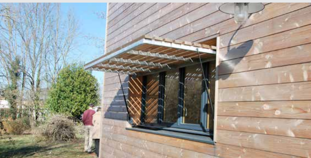
Le menuisier SMCC a lui-même fabriqué les volets bois, battants ou coulissants et le brise-soleil, qui protègent de la surchauffe estivale.
