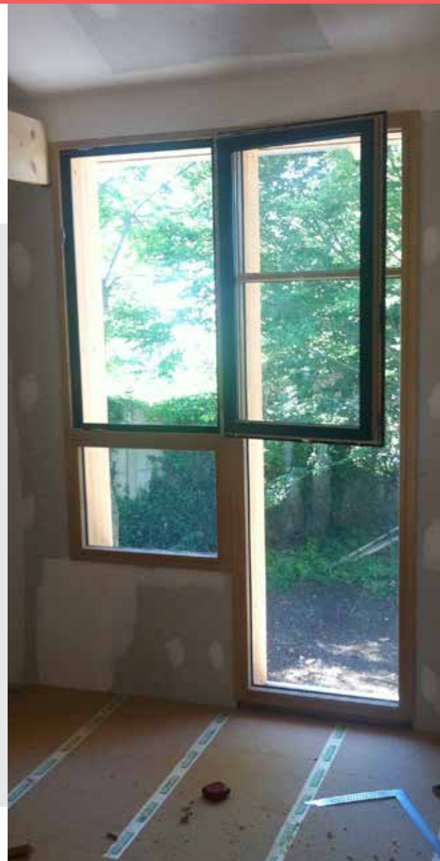
Les menuiseries mixtes bois-alu sont posées. L'isolation du sol est en fibre de bois pour ses qualités phoniques.
