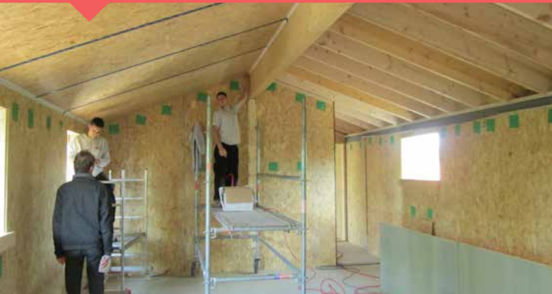
L'étanchéité à l'air a, bien sûr, fait l'objet de toutes les attentions. L'OSB joue ici le rôle de pare-vapeur. La ouate a été insufflée derrière.
