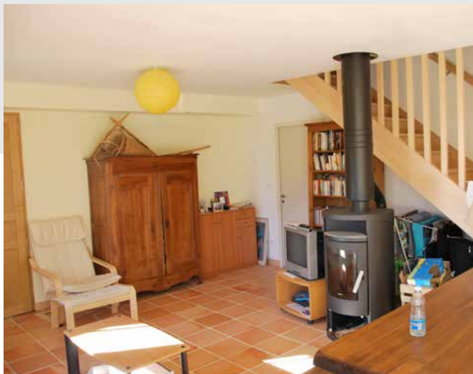
Le chauffage est intégralement assuré par le poêle à bois performant.
