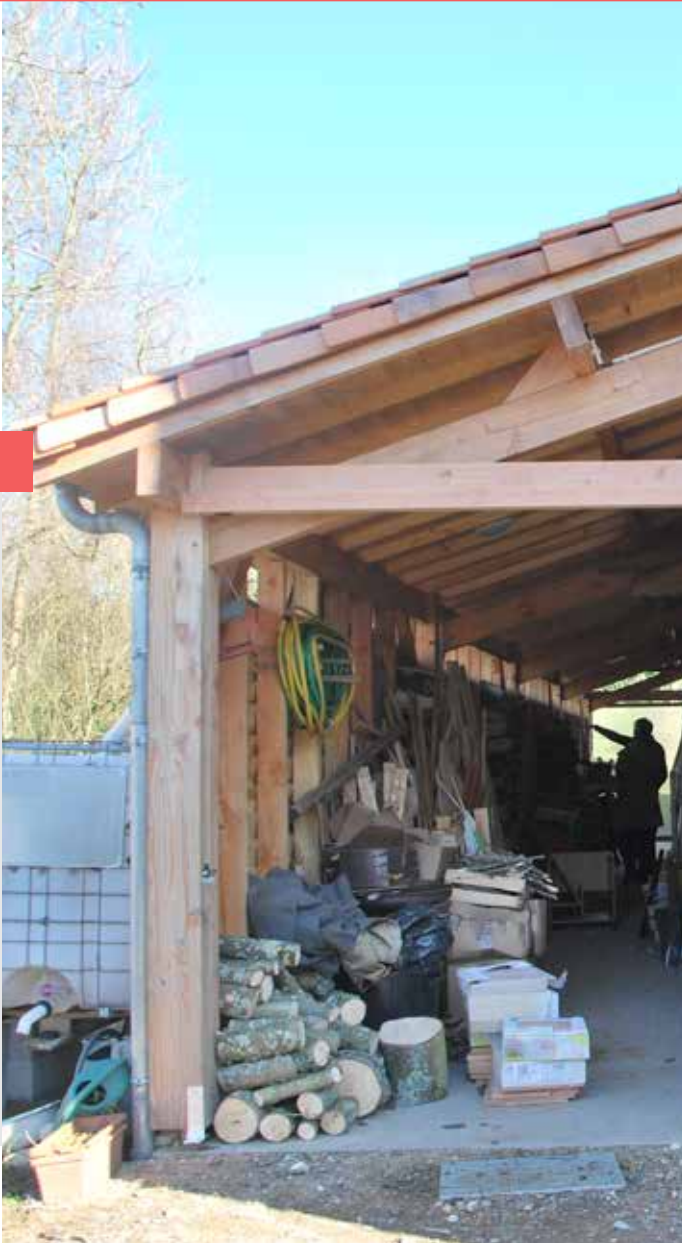
Côté nord, un grand atelier, espace commun, protégé du froid et du vent.
