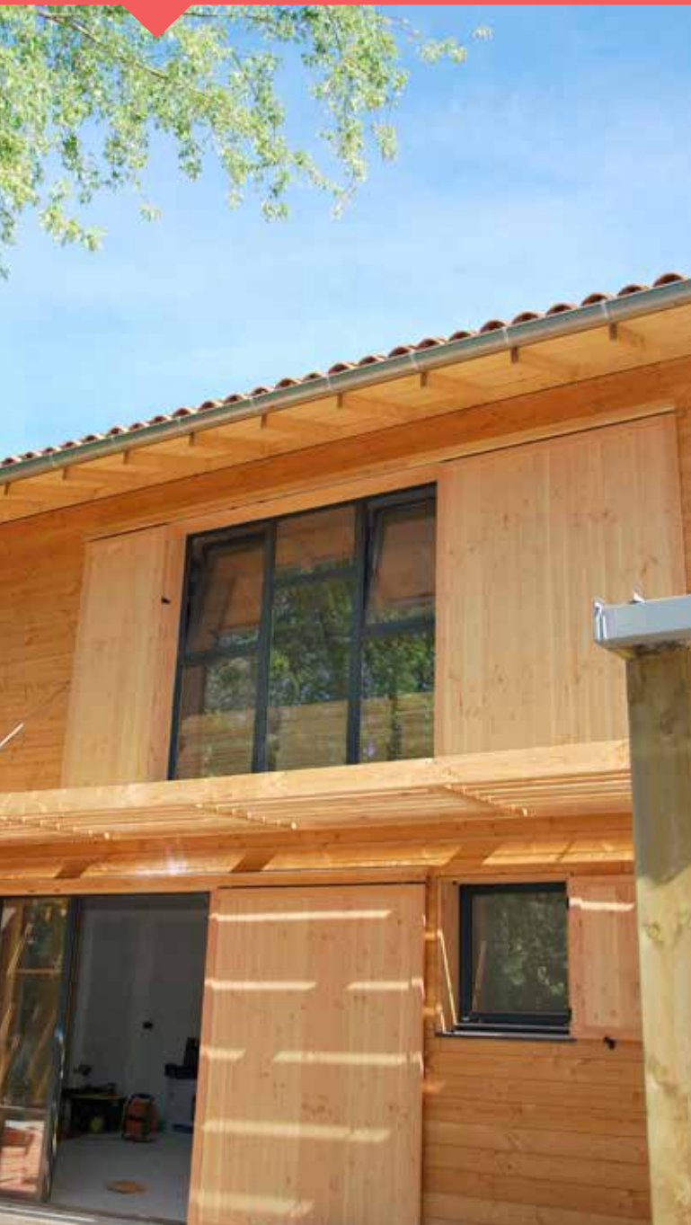
Les volets coulissants permettent de gérer parfaitement les période de surchauffe.
