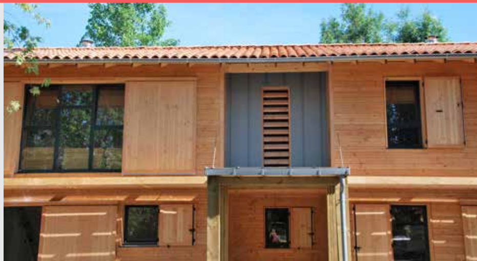
Une façade rythmée grâce à une discrète présence de bardage zinc et des volets coulissants efficaces.
